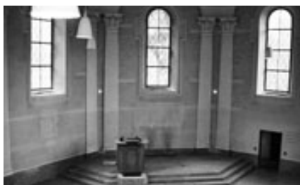
Der Chorraum vor der Renovation
