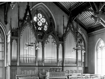
Originalansicht Kirche Zürich-Unterstrass um 1900
