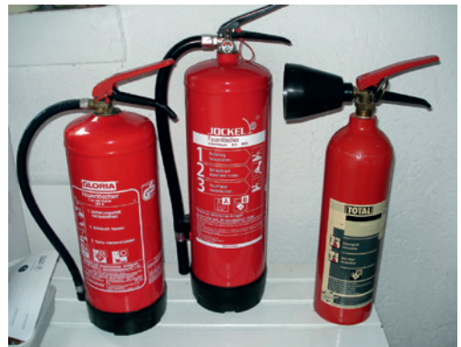
Drei Feuerlöscharten (v.l.n.r.: Pulverlöscher 6 kg, Schaumlöcher 6 l, CO 2 -Löcher 2 kg)
