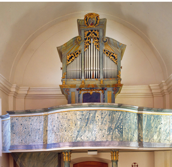
Die Orgel von Vignon (heute in der Kapelle S. Gudegn) – das einzige Kayser-Instrument mit original erhaltener Windlade, mit dem für diesen Orgelbauer typischen Pedalkoppelsystem.
